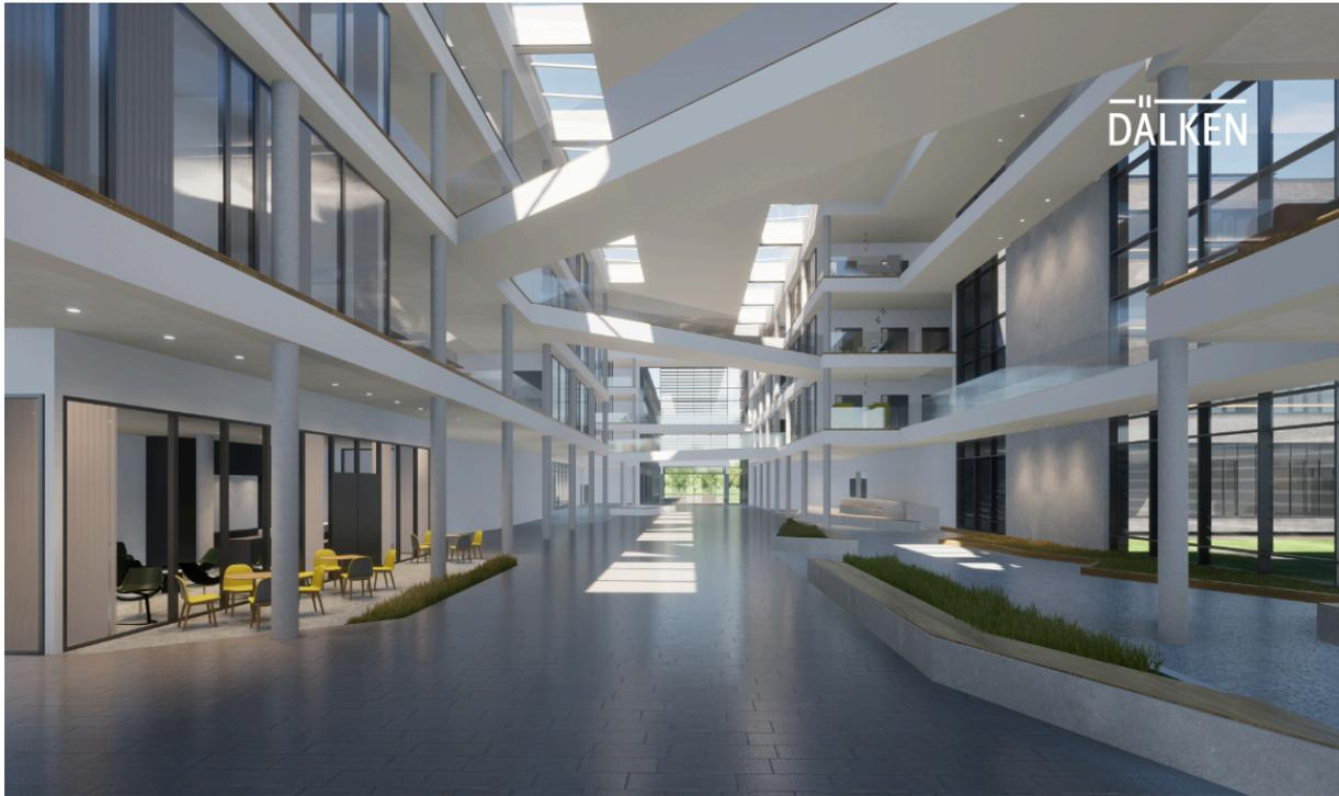
Die Magistrale wird in einer Pfosten-Riegel-Konstruktion ausgeführt, sodass ein helles und freundliches Ambiente im Innenraum entsteht. (Visualisierung: Dälken Architektur + Generalplanung)
